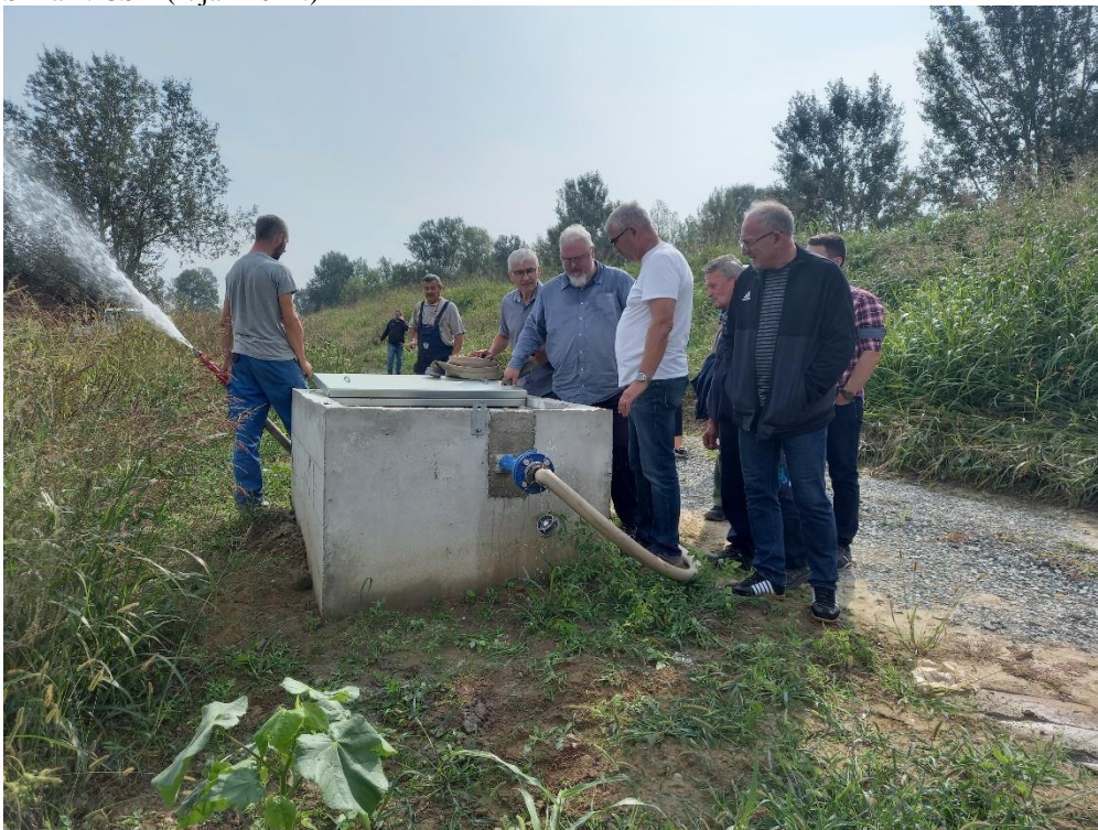
Slika 3. Spojno okno (hidrant) (rujan 2021.)
