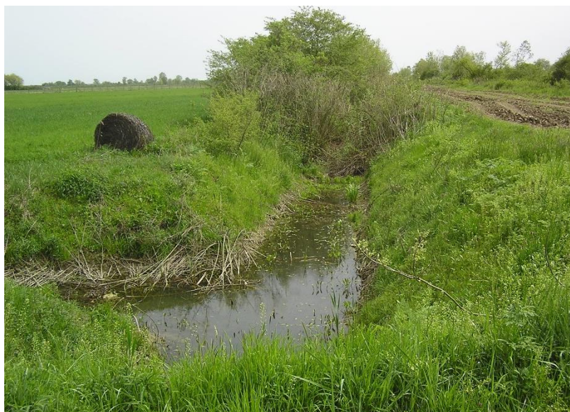
Slika 3.3.4. Spoj dobro i nedovoljno održavanog kanala IV. reda (Foto: k.o. Slavonski Kobaš, 12.04.2016.)
