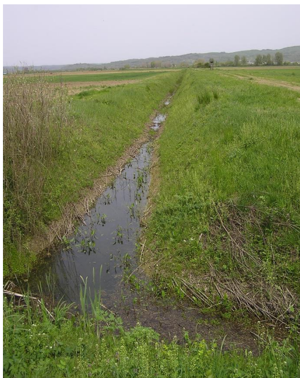
Slika 3.3.3. Dobro održavan odvodni kanal IV. reda (Foto: k.o. Slavonski Kobaš, 12.04.2016.)
