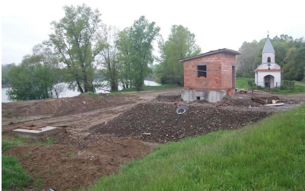
Slika 3. Objekt za elektroopremu crpne stanice 1
