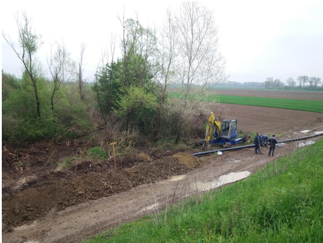
Slika 5. Polaganje dodatnog cjevovoda („južni“ korisnici)
