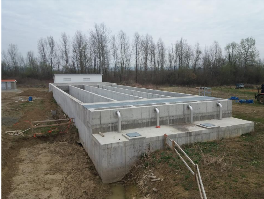
Slika 1. Crpna stanica 2, Retencijski bazen i Taložnica te Trafostanica
