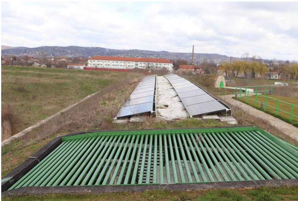
SLIKA 11: SOLARNA ELEKTRANA U TVRĐAVI BROD
